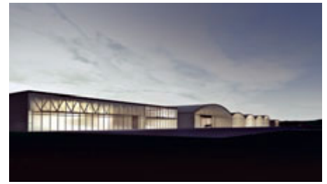
Hangars für Unterhalt und Stationierung.
