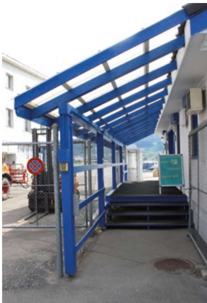
Die neu bemalte Eingangspartie.
