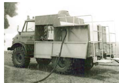
1966 war dieser Unimog das neueste Löschfahrzeug.
